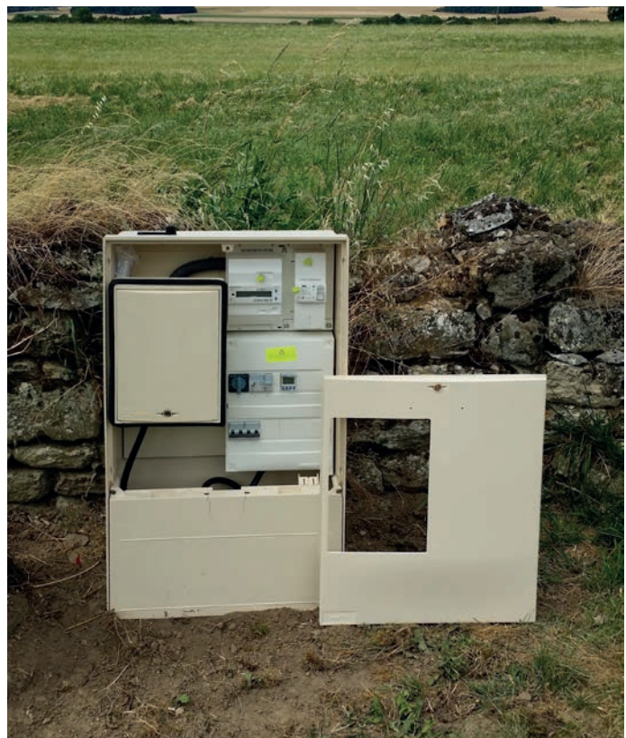
Exemple d'application pour un coffret REMIC 450 avec CIBE intégré :
