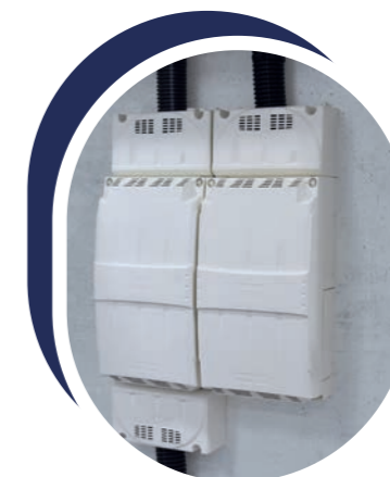
SPCM placés dans un parking comportant 2 travées
