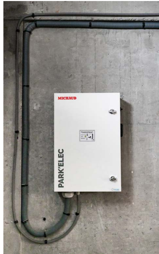
Exemple d'armoire de recharge "tout en un"
